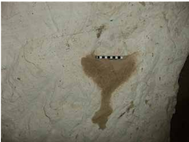
איור 20: מכרה 35/29, נזילת שמן תחת גומחת נר
