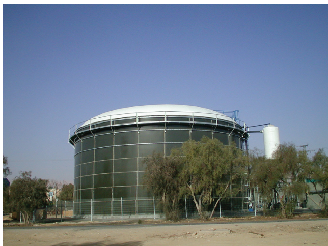
איור 1: מתקן הביוב במחלבת יטבתה
